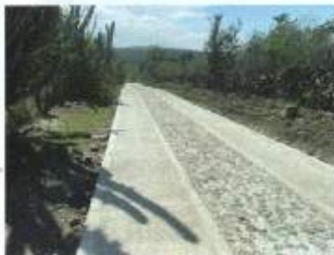
**Obra:** Construcción de Rampa de concreto Hidráulico de placa-huella en la comunidad de San Ramón, municipio de Lagunillas, S.L.P.
