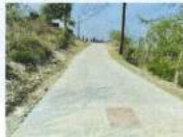
**Obra:** Construcción de Rampa de concreto Hidráulico de placa-huella en la comunidad de Encinillas, municipio de Lagunillas, S.L.P.
