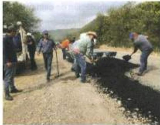
**Obra:** Rehabilitación de camino carrizal de San Juan de Abajo – El Quelitalillo mediante bacheo superficial aislado, municipio de Lagunillas, S.L.P.
